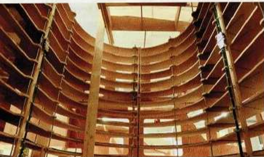
Versteckt unter wuchtigen Gebirgsmassiven überwinden die Modellzüge Höhenunterschiede von mehr als drei Metern. Der Wendelturm ist für Wartungszwecke von innen begehbar.
